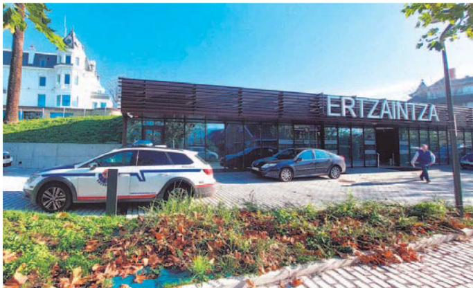
El nuevo edificio anexo de 4.000 metros cuadrados acogerá las áreas de atención a la ciudadanía e investigación. L.R.
